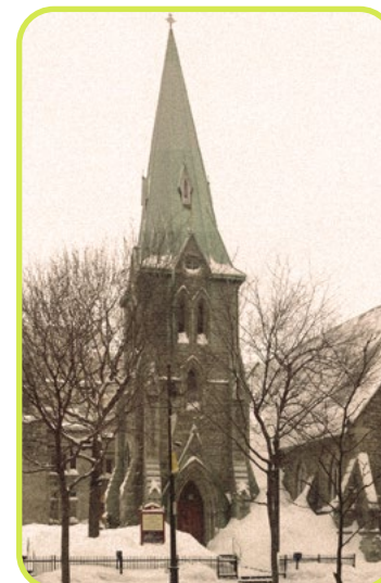
Espace Jax : La requalification de l'église anglicane Saint-Jax
