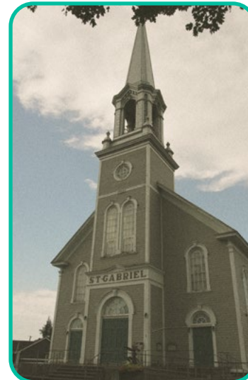
Centre multifonctionnel de la Durantaye : La requalification de l'église catholique Saint-Gabriel
